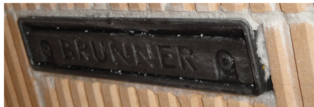
Abb. 4: Faserfilz um Düse
